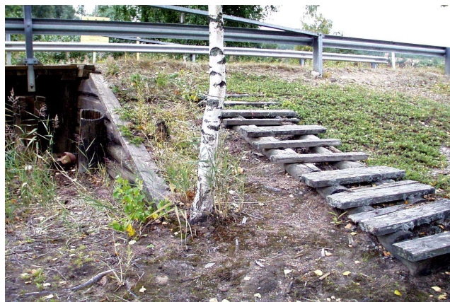
Kuva 3. Yksinkertaiset puuportaat ovat lahoamassa käyttökelvottomiksi.
