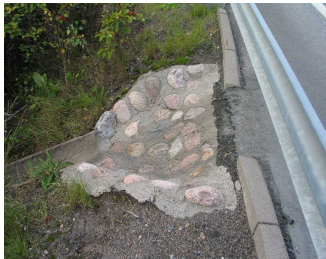
Kuva 10. Pintavesien ohjauksessa voi yhdistää erilaisia kuivatusrakenteita.
