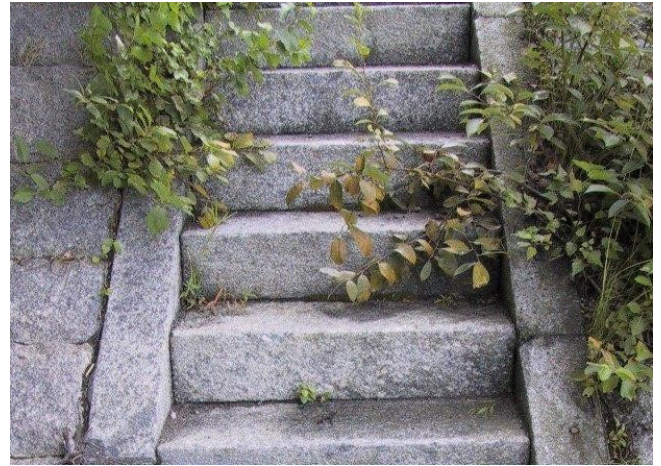
Kuva 6. Kiviportaatt vaativat erityisen huolellisesti rakennetun asennusalustan.
