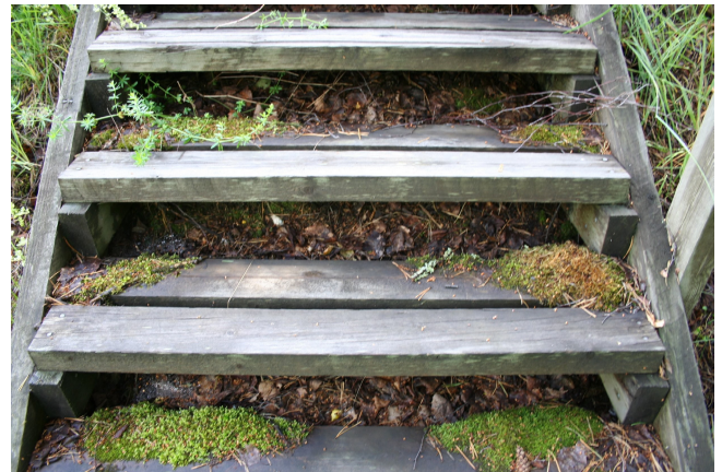
Kuva 7. Tyypilliset puiset portaatt, joiden kunnossapidosta ei ole huolehdittu.
