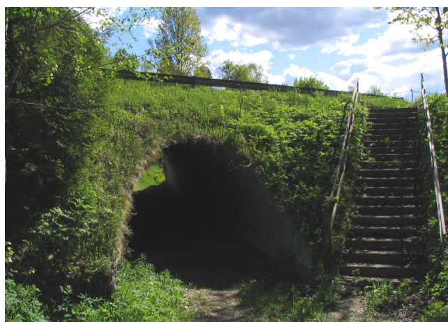
Kuva 4. Verhoukseen sulautuvat luiskaportaat.
