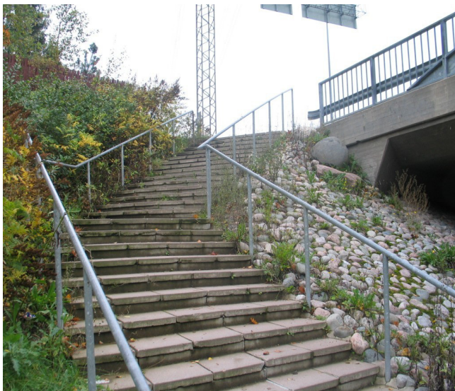
Kuva 2. Alikulkukäytävästä linja-autopysäkille johtavat betonilaatoista rakennetut portaat.
