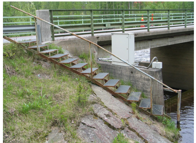
Kuva 8. Teräsportaatt jyrkässä luiskassa.
