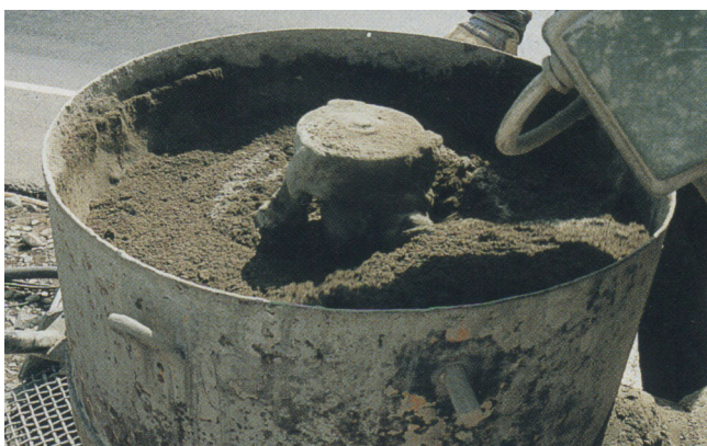
Kuva 1. Betonimassa valmistetaan betoninsekoittajalla.
