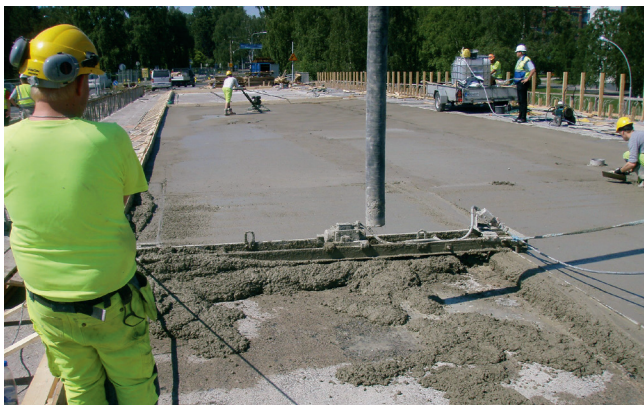
Kuva 2. Muotoiluvalun teossa käytetään tärypalkkia.
