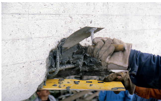
Kuva 1. Paikkausta valumattomalla paikkauslaastilla.
