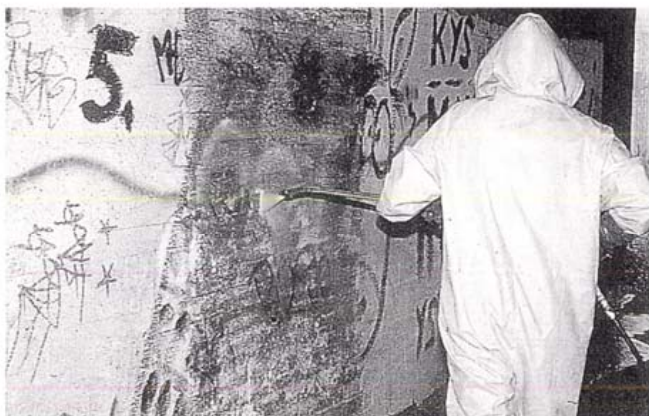
Kuva 3. Pinta puhdistetaan painepesurilla.
