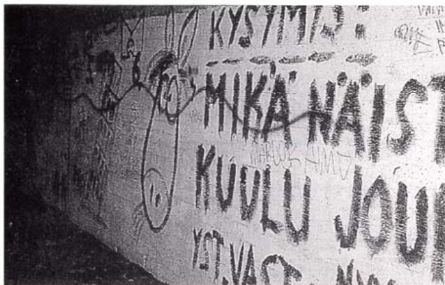
Kuva 1. Töherryksiä alikulkukäytävän seinässä.
