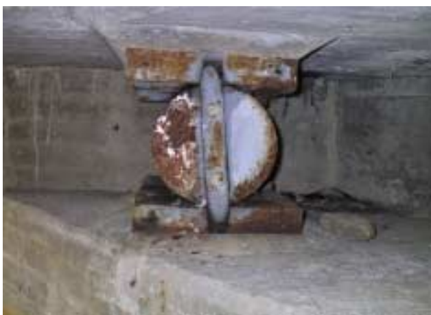
Kuva 1. Huoltokäsittelyn tarpeessa oleva teräksinen rullalaakeri.
