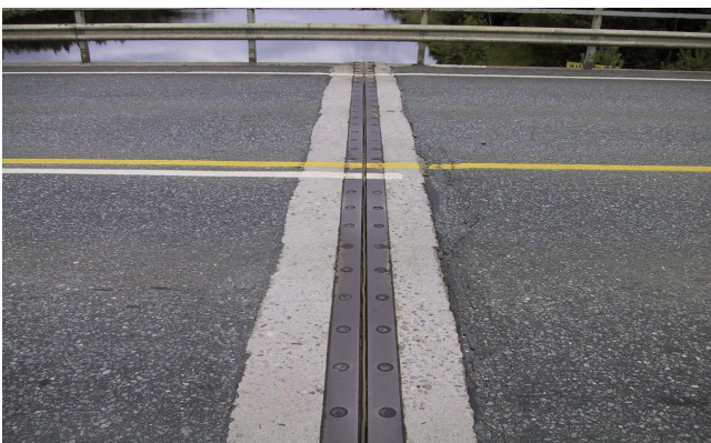
Kuva 2. Keskisuuri liikuntasaumalaite
