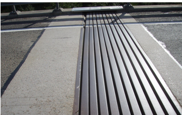
Kuva 3. Suuri liikuntasaumalaite
